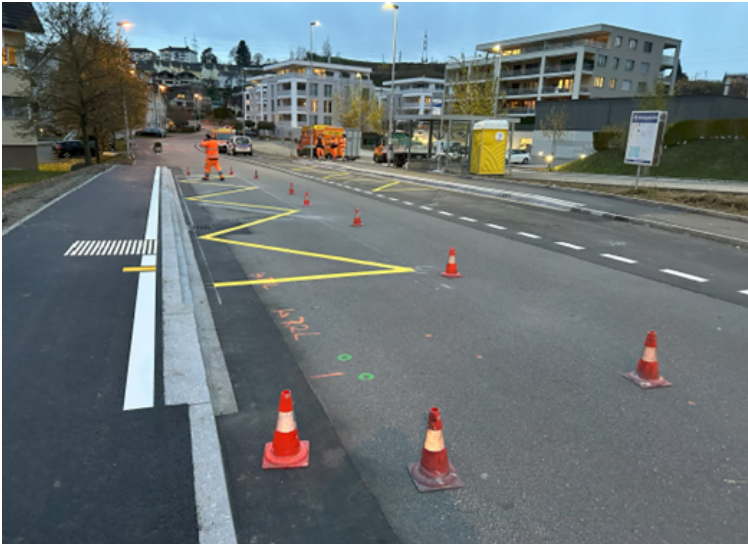
Fertigstellung Bushaltestelle in Immensee, Dezember 2023
